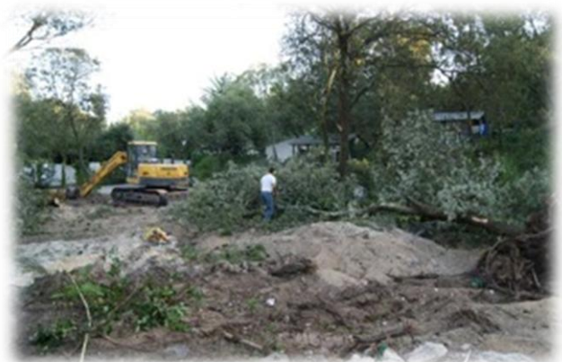
sloop en bouwrijp maken
