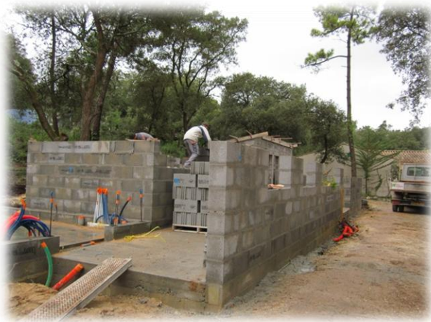
nieuw sanitairblok in aanbouw
